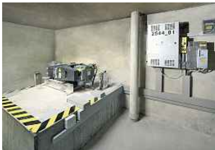
El variador DR VAB asociado a un cuadro de maniobra CO BX y una máquina DR SGB 142.
