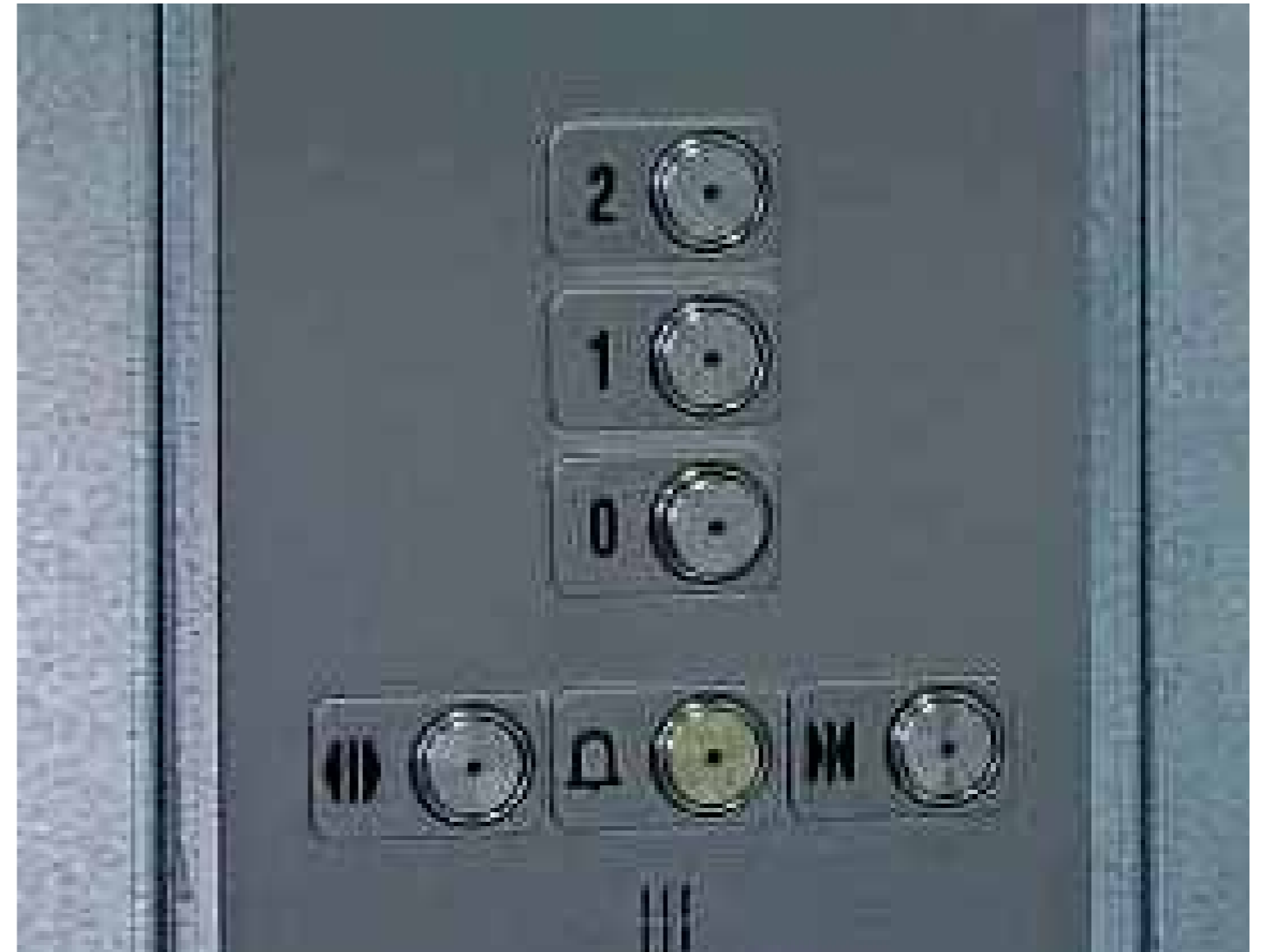
Botonera de cabina de acero inoxidable, con protección antivandalismo
