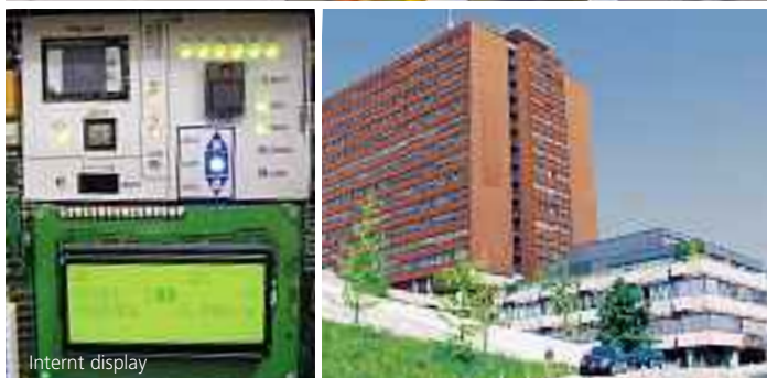
Elevatorstyring og frekvensomformer
