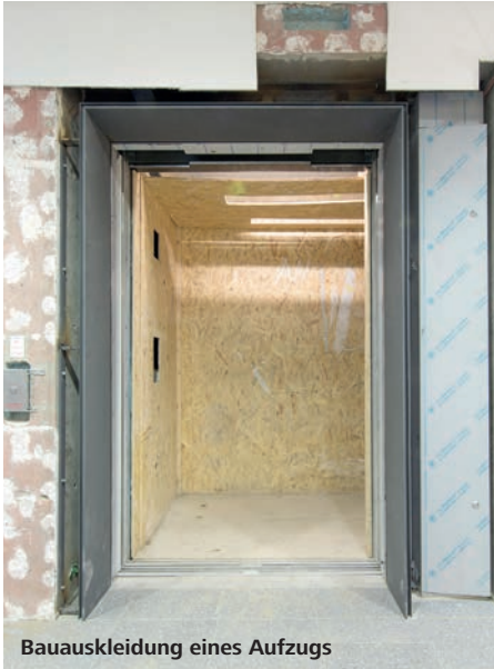
Kabinentüren mit Schutzfolie
