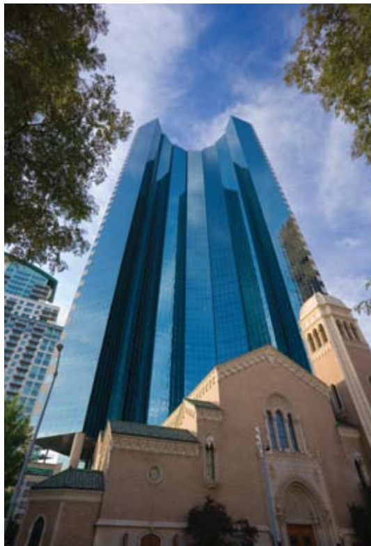
Photo ci-dessous : Les angles du toit de l'église Holy Ghost sont en communion parfaite avec la géométrie du 1999 Broadway, qui s'élance vers le ciel.
