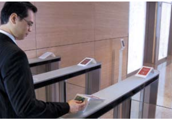
Photo de gauche : Le système PORT permet le contrôle d'accès et la manœuvre à enregistrement de destination à l'aide de lecteurs de cartes et d'écrans tactiles. Photo de droite : Le spectaculaire gratte-ciel ICC, à Hong Kong, un des premiers à avoir intégré le système PORT Technology de Schindler.
