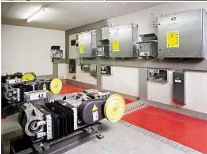
Instalación comercial triplex. El variador de frecuencia DR VAB vinculado con un cuadro de maniobra CO MX. Equipado con una máquina DR SGB 142.
