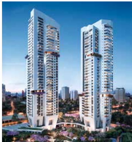
EZ Parque da Cidade, 住宅楼, 圣保罗, 巴西 14台电梯, 包括12台Schindler 5500和2台Schindler 3300
