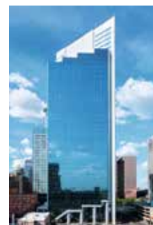
Two22, 办公楼, 明尼阿波利斯市, 美国 以PORT技术改造19台电梯
