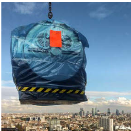
Einer der Hochleistungsmotoren für den Libeskind Tower wird per Kran nach oben gehievt.
