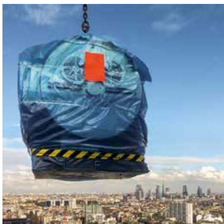
起重机正吊起一个用于Libeskind Tower的高性能主机。
