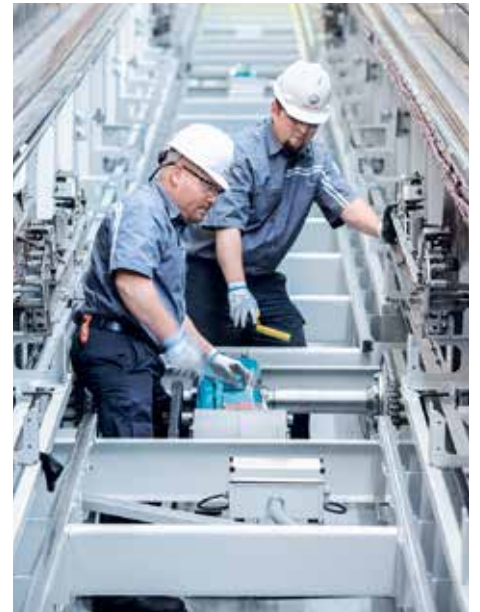
使用“InTruss”方案更新改造自动扶梯
