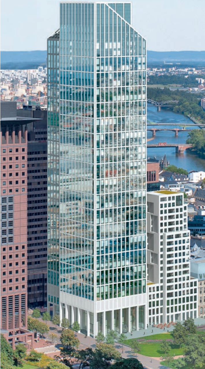
TaunusTurm, Bürogebäude; Frankfurt, Deutschland
