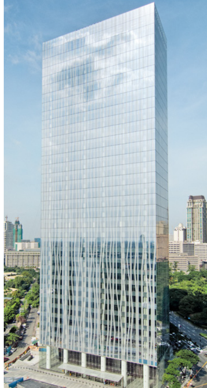
Zuellig Building, 办公楼: 马卡蒂, 菲律宾
