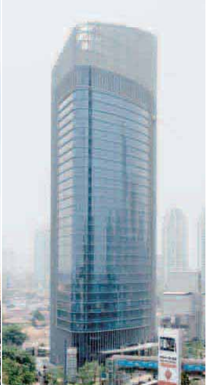
City Tower，办公楼，雅加达，印度尼西亚
