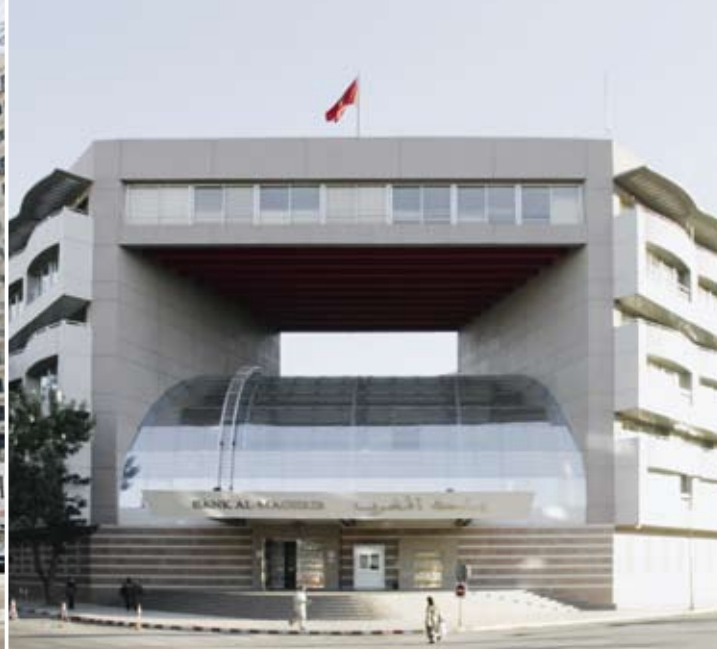
Bank Al-Maghrib, Bürogebäude; Rabat, Marokko
