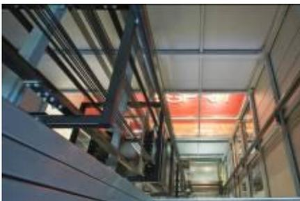
Nicht sichtbare Schachtkomponenten werden mit einem Grundanstrich versehen, dessen Zusammensetzung durch die DGNB-Richtlinien festgelegt ist.
