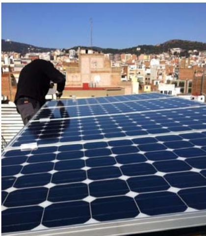
Die Solarpanels sind so dimensioniert, dass der Betrieb des Aufzugs auch in den sonnenärmeren Wintermonaten sichergestellt werden kann.
