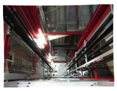
Optimale Raumnutzung: Trotz des hohen Standardisierungsgrades lassen sich Aufzugsmodelle wie der Schindler 6300 in 10-mm-Schritten flexibel den Schachtbegrenzungen anpassen.
