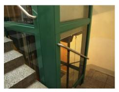
Steht ein ausreichend breites Treppenauge zur Verfügung, kann innenseitig ein komplettes Schachtgerüst nachgerüstet werden.
