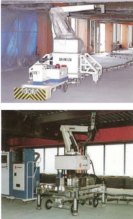
图 9. 这些单项任务机器人由 Shimizu 于 20 世纪 80 年代开发，执行钢结构防火喷涂等活动。© Shimizu Corp.
