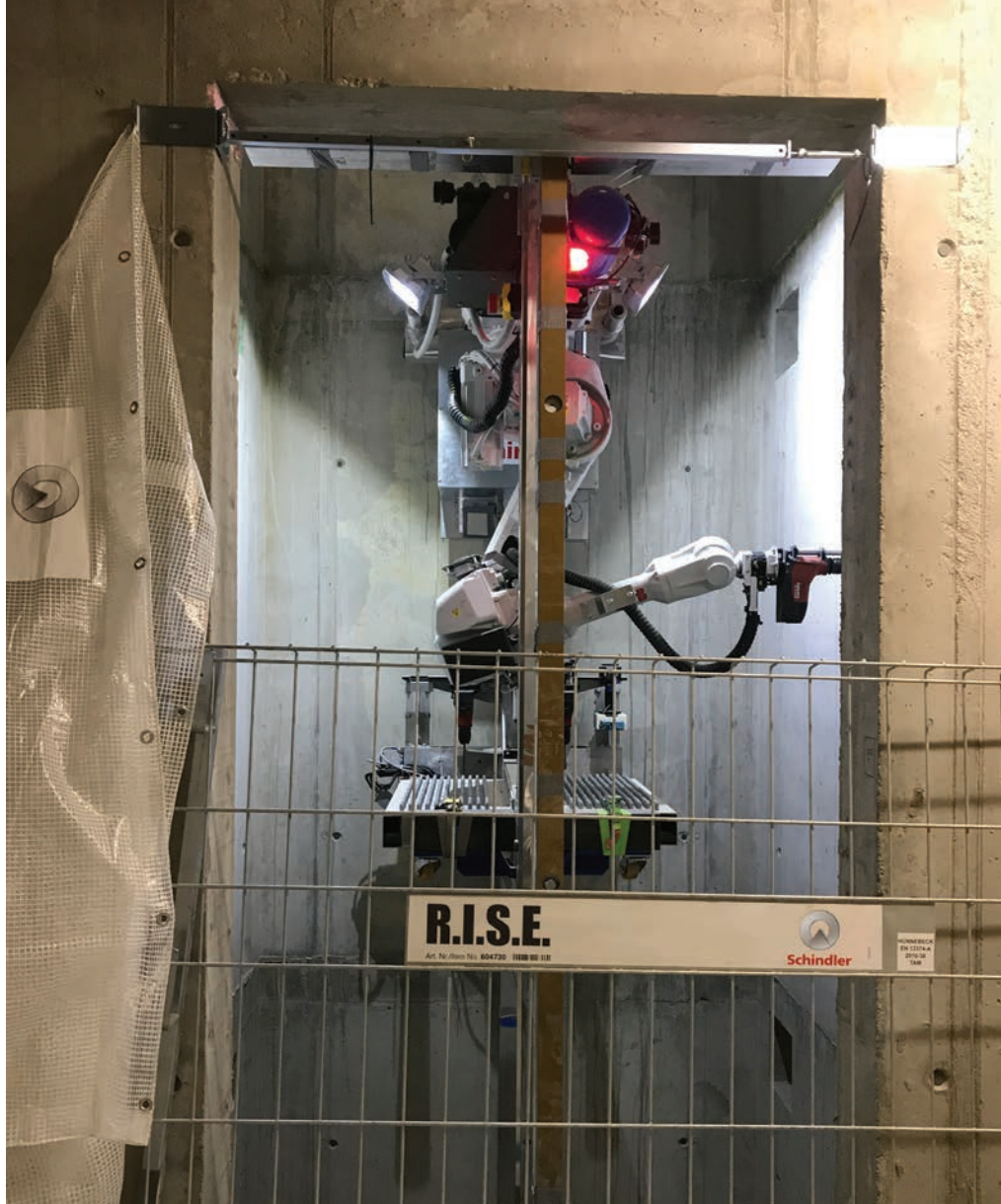
图 16. 自攀升机器人电梯安装系统（迅达 Schindler R.I.S.E.）集成数字建图设备技术，引导电梯系统的自动安装。
