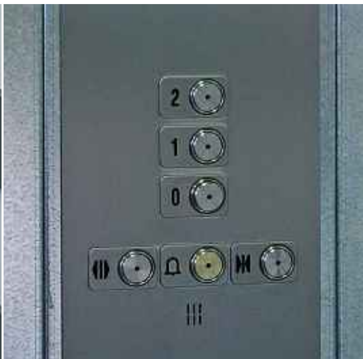
Bottoniera di cabina in acciaio inox, anti-vandalismo
