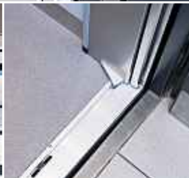
Führungsschuhe gewährleisten ruckfreies Öffnen und Schließen
